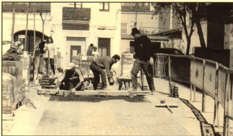
Remodelació del carrer Sant Carles
